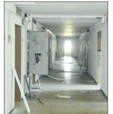
Licht am Ende des Tunnels: der Flur des Verwaltungsgebäudes.
