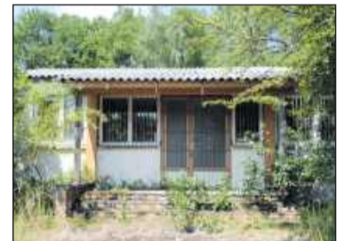
Der Zahn der Zeit nagt: Hier war mal eine Bowlingbahn im Gebäude.
